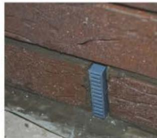
Их размещают в вертикальных швах кладки. Кроме вентиляции и дренажа, вставки предупреждают попадание насекомых внутрь кладки.
