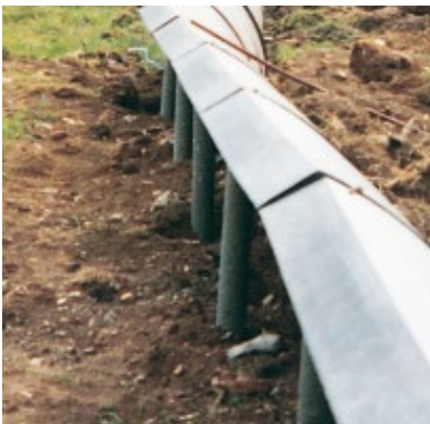
Užtvartos skydų montavimas ir užpylimas gruntu
