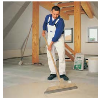
Knauf Nivellierspachtel 415 yra savaime išsilyginantis anhidritinis mišinys ir idealiai tinka sausoms grindims glaistyti
