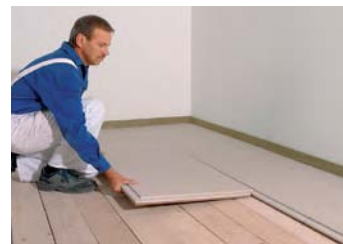
Sekančios Brio plokštės klojamos standžiai pristumiant prie anksčiau paklotų ir...
