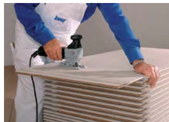
Knauf Brio plokštės galima pjauti tiek su siaurapjūkliu, tiek su diskiniu pjūklu
