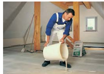
Knauf Nivellierspachtel 415 yra savaime išsilyginantis anhidritinis mišinys ir idealiai tinka sausoms grindims glaistyti
