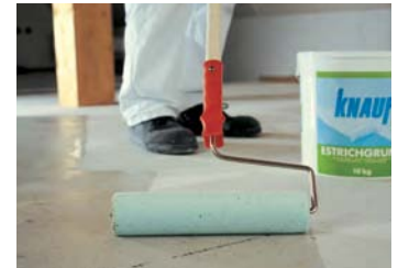
Paviršius gruntuojamas su gruntu Knauf Estrichgrund, praskiestu vandeniu [1:1]
