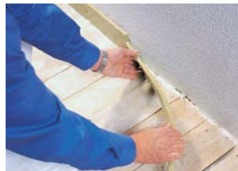
Prie visų sienų, atramų ir pan. priklijuojamos kraštų izoliacijos juostos
