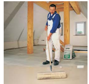
Apdorojus išlietą sluoksnį su adatiniu voleliu, paviršius tampa ypač lygiu
