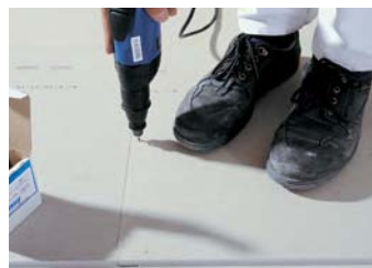
...„špunto“ zona sutvirtinama savisriegiais arba kabėmis. Tai užtikrina saugų plokščių suklijavimą.
