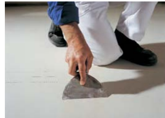
Plokščių sandūros užtaisomos su Knauf Uniflott
