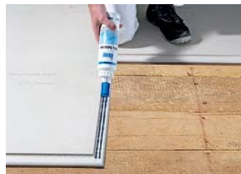
„Špunto“ zona padengiama siūlių klijų Knauf Brio Falzkleber dviem juostomis
